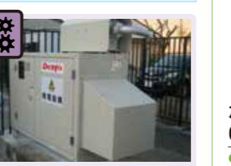
福祉施設の事例です。自家発電装置TGL-45SPGFの事例です。スプリンクラーや消火栓ポンプ等防災設備のバックアップ電源として設置されています。
