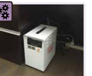
非常用電源があれば、最低限の電気を確保できます。電源は常時接続状態でパソコンのUPSとしても使用できます。コンパクト・軽量で女性でも移動が可能です。
