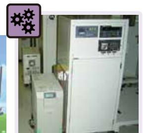
無停電電源装置はサーバのみではなく、突然停止すると被害が大きいガス除害装置にも使用されます。
